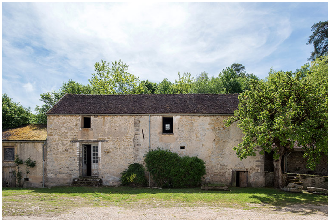
Bâtiments agricoles au sud de la cour.
