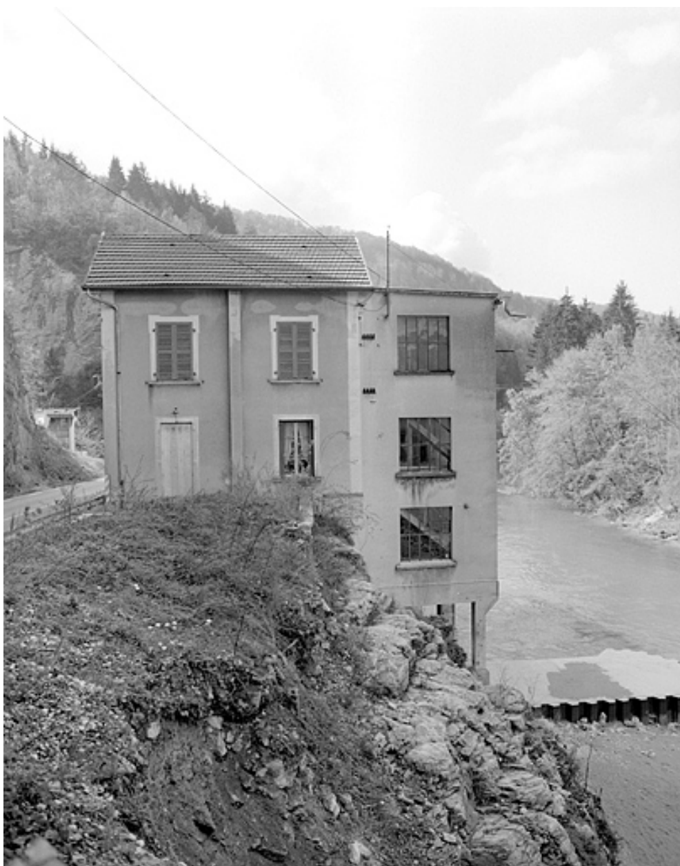
Façade postérieure de la centrale.
