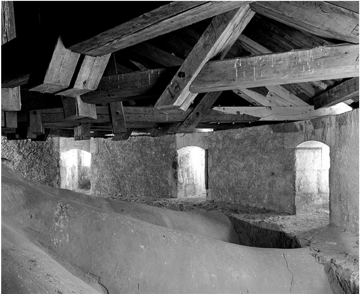
Ouvertures des échauguettes sur l'intrados des voûtes de l'abside.
