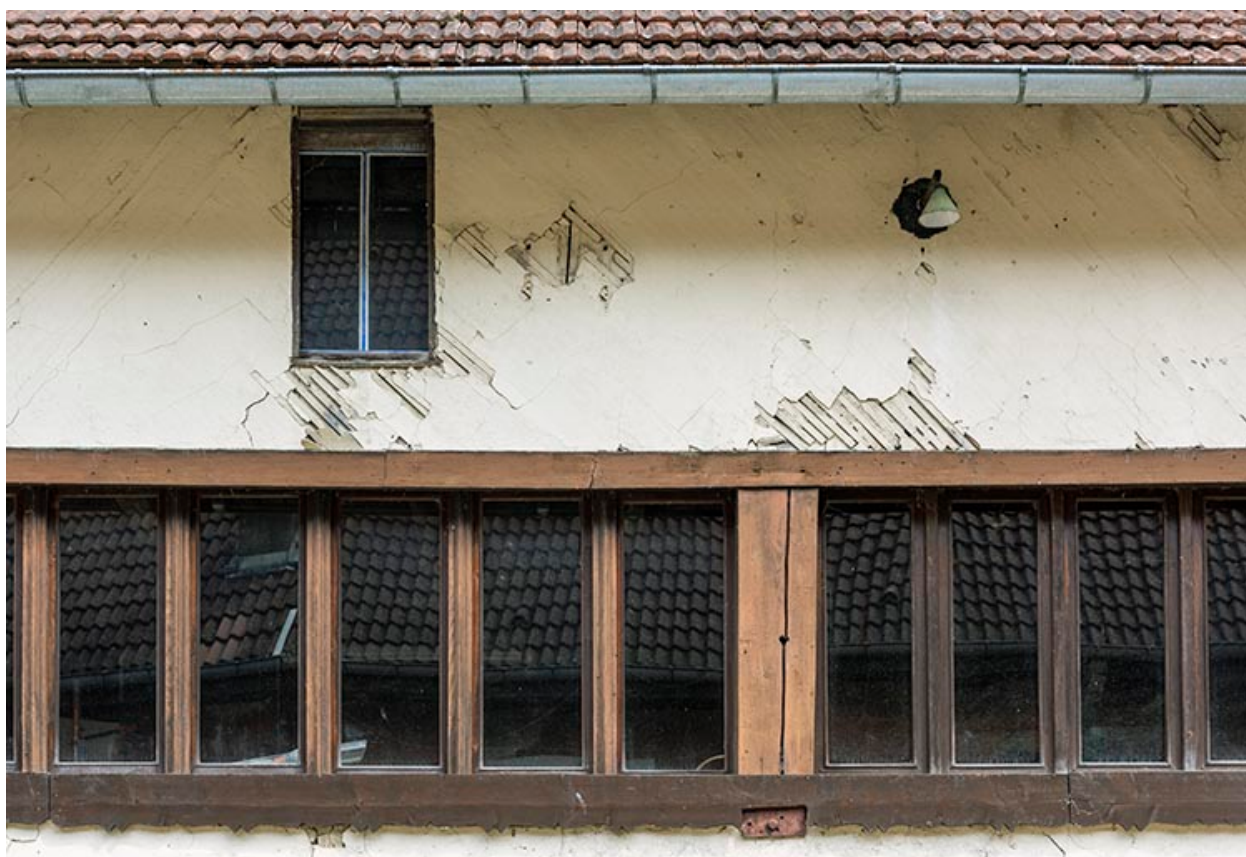
Forge (façade ouest) : fenêtres multiples et lattis de plâtre.
