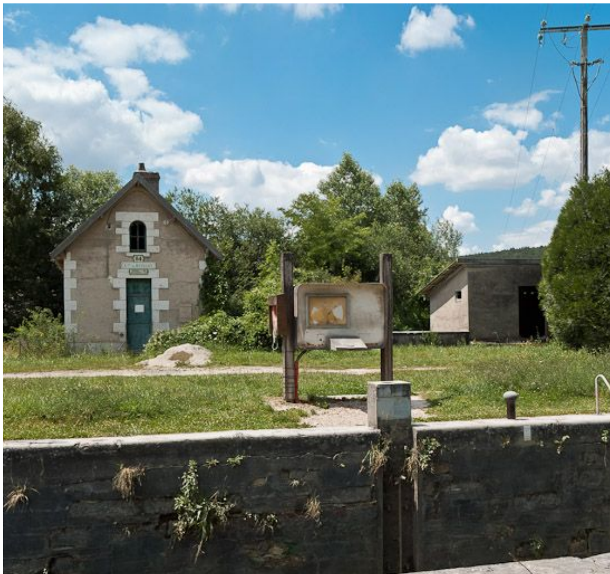
Vue d'ensemble du site d'écluse.
