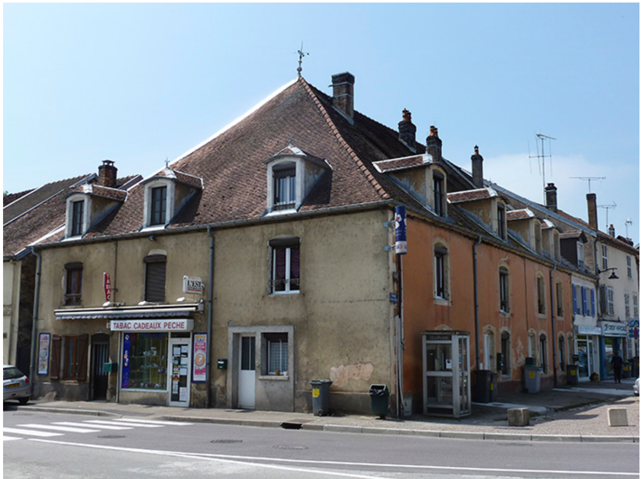
Façade sur la rue du Général Détrie.
