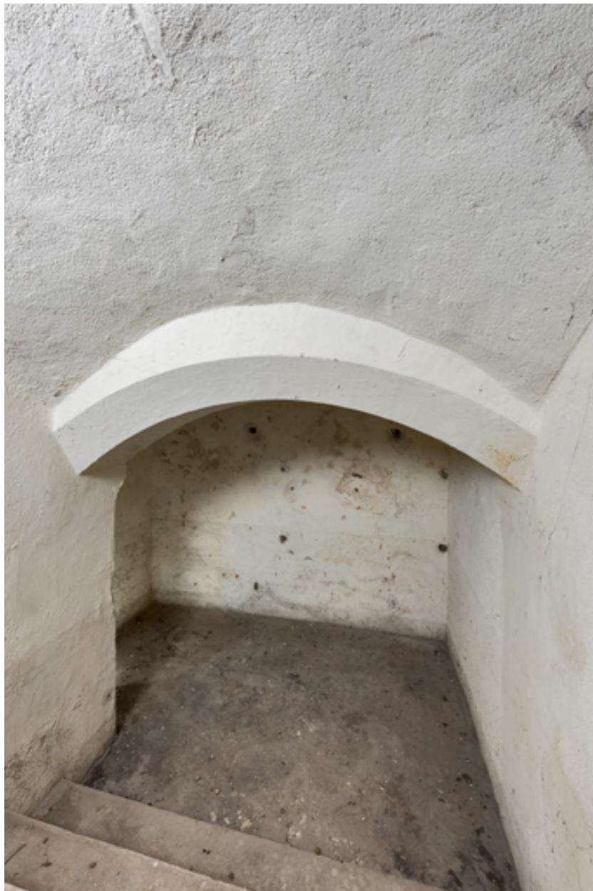
Salle du sous-sol, vestige d'une porte de cave.
