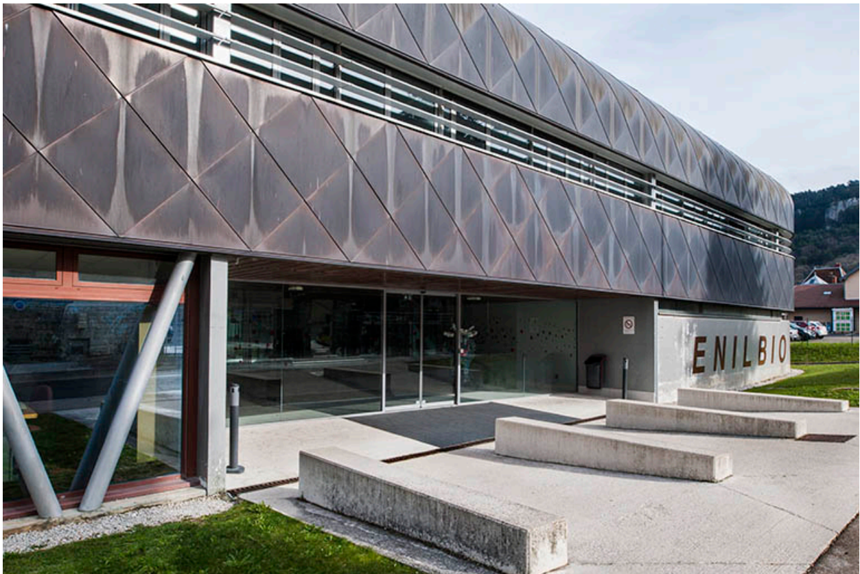
Détail de la façade d'entrée sud sur rue de la halle de génie alimentaire.
