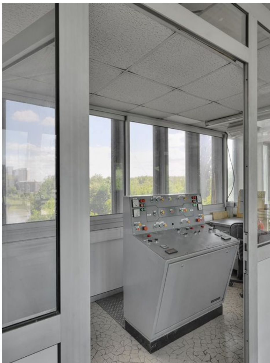
Vue intérieure de l'ancien poste de commande.
