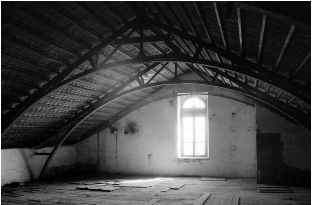
Ancien atelier de fabrication (b2), étage en surcroît : détail de la charpente et mur pignon est.
