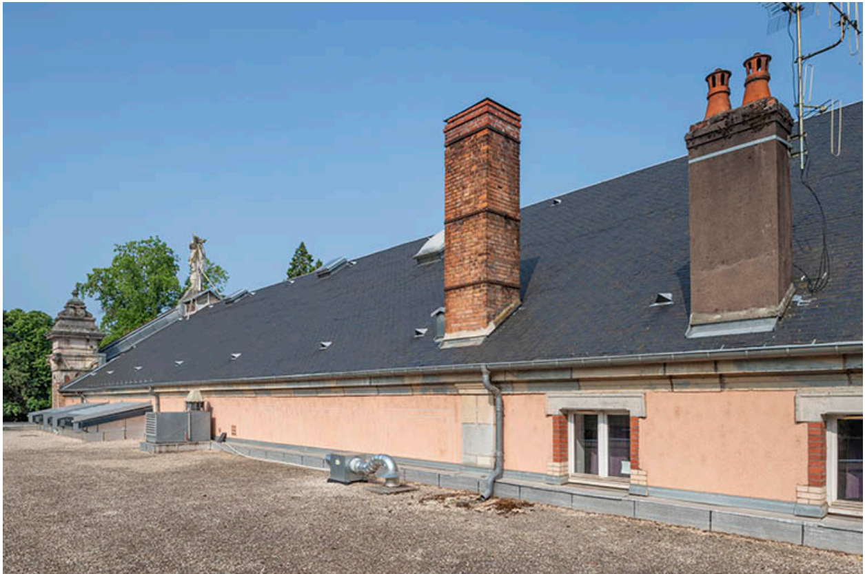
Toiture, vue depuis l'est.
