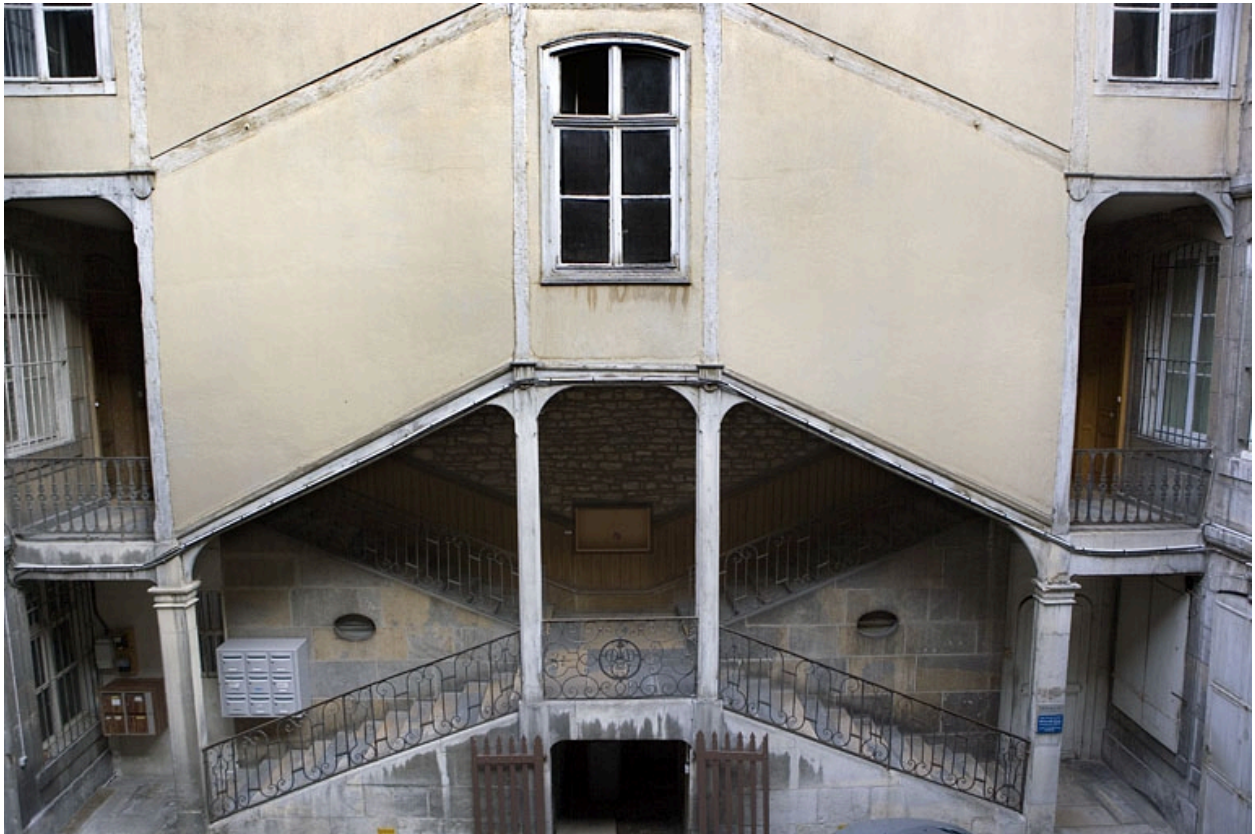
Vue d'ensemble de l'escalier à cage ouverte droit, de face, depuis l'escalier gauche.
