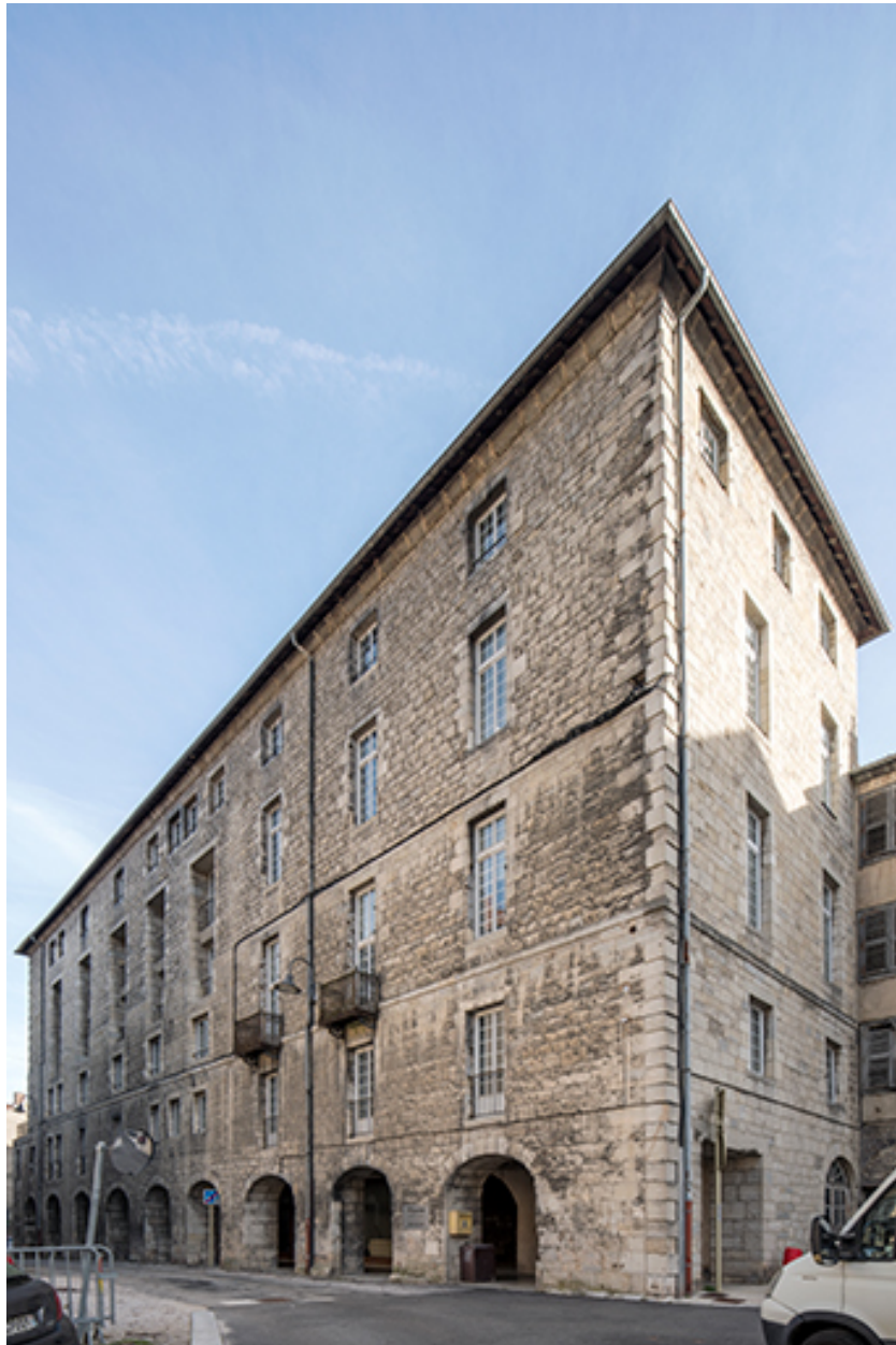
Elévation sur rue depuis le sud-ouest.
