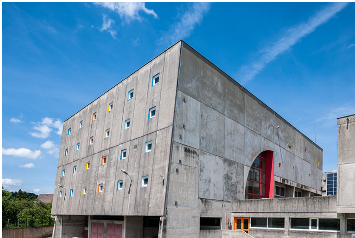
Atelier béton : façade latérale nord.
