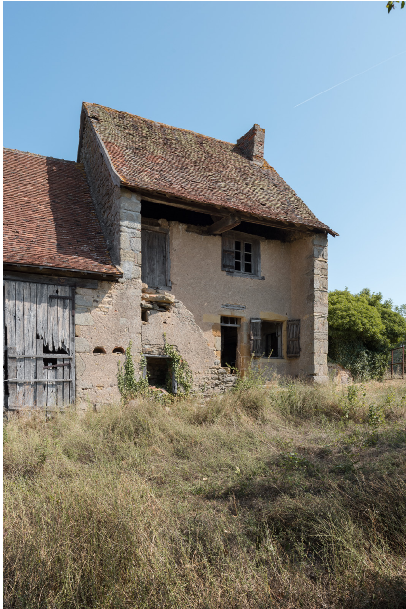
Vue de trois quart sud-ouest de la maison ferme.
