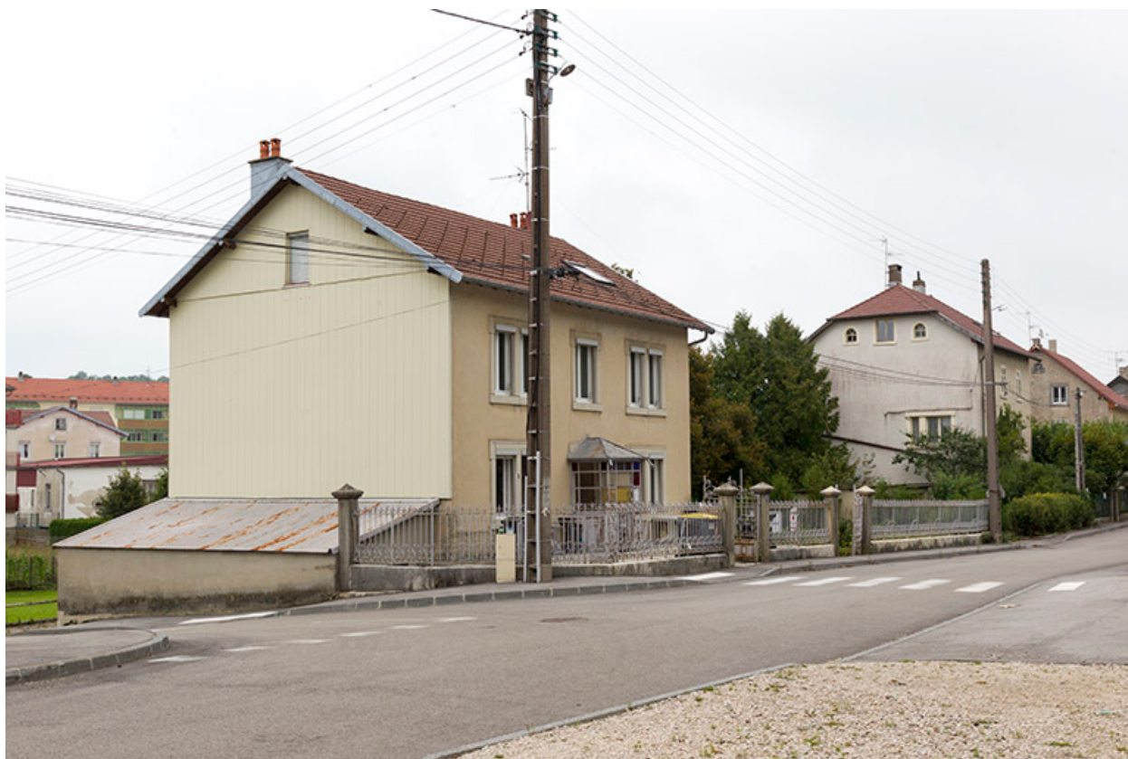
Façades antérieure et latérale gauche.
