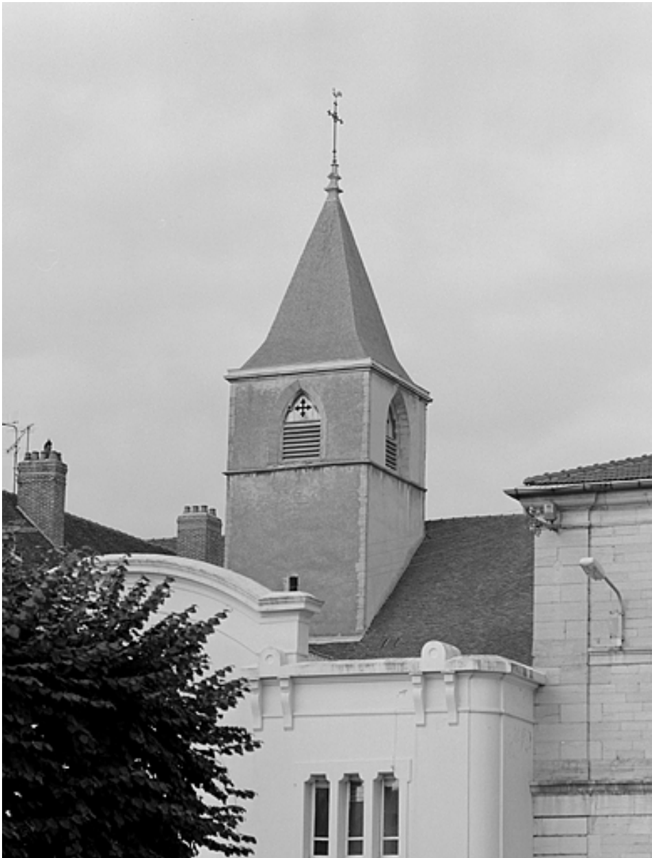
Clocher de l'église vu depuis la rue Pasteur.
