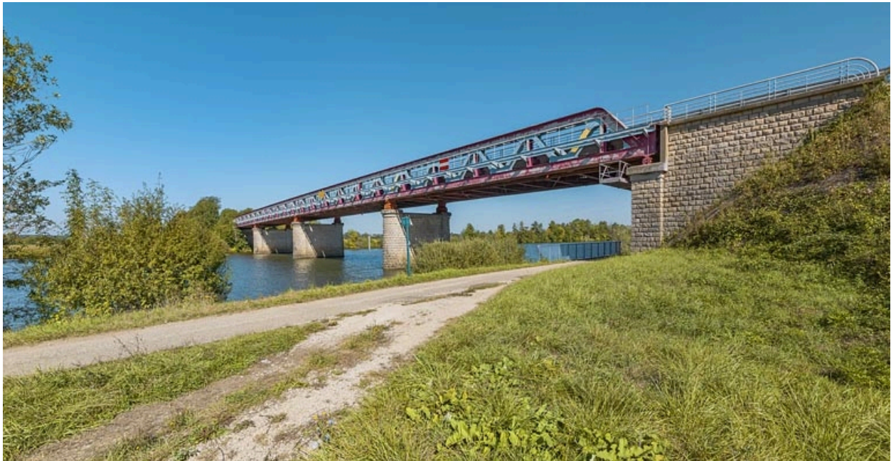
Vue d'ensemble du pont.
