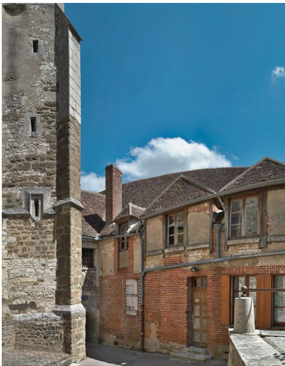
Façade postérieure du bâtiment sud-ouest.
