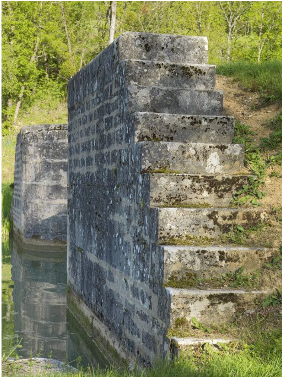
Tête aval du sas : l'escalier.
