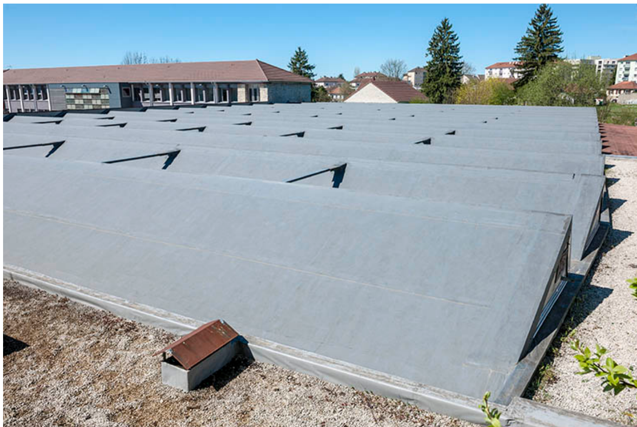
Atelier, site Edouard Herriot, toiture en sheds.
