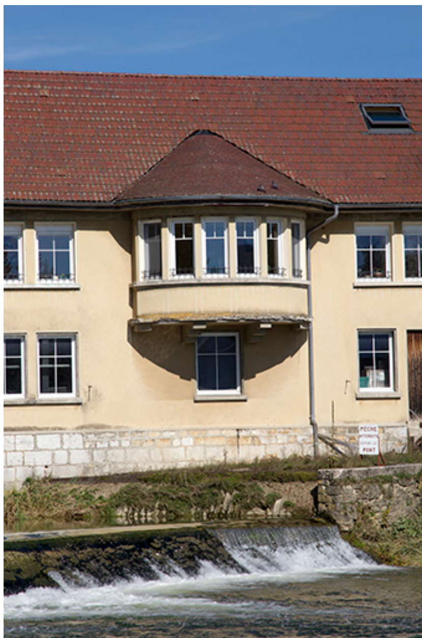
Façade postérieure : oriel.
