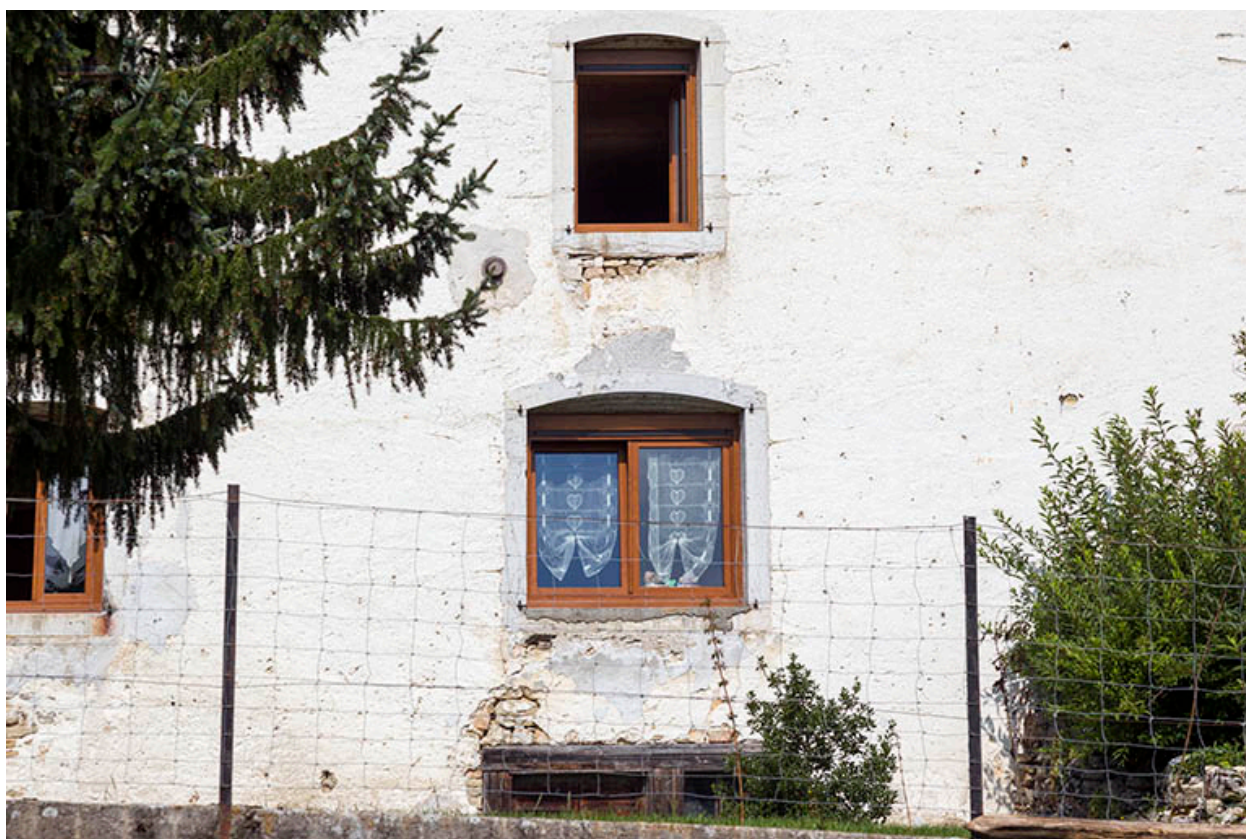
Façade est : fenêtres.
