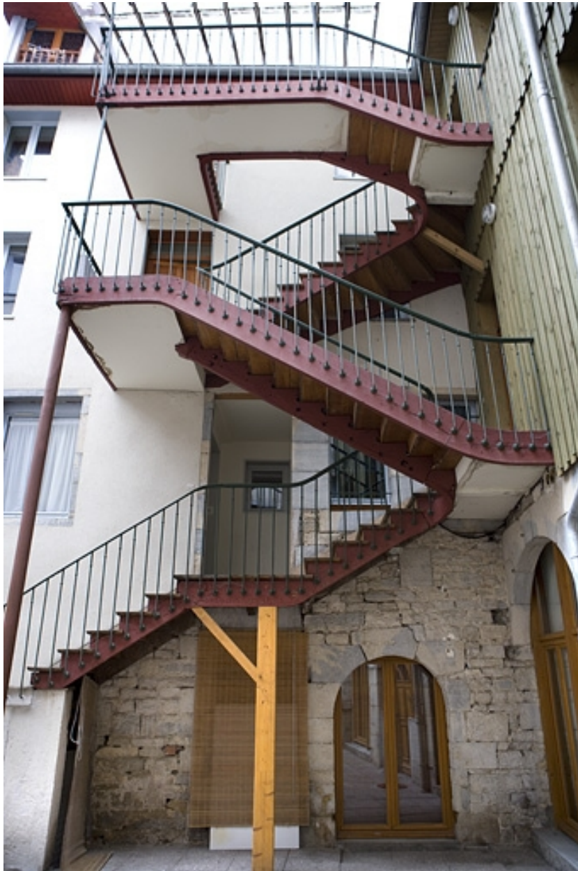
Deuxième cour : escalier extérieur récent.
