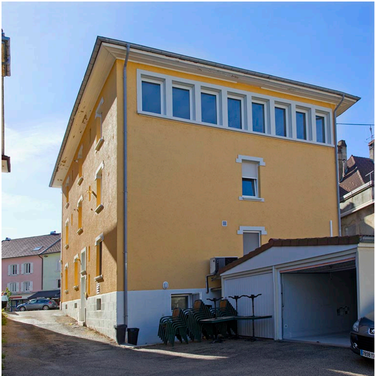
Façades postérieure et latérale droite.
