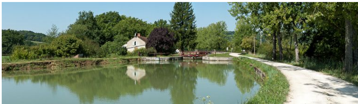
Vue du site d'écluse depuis l'amont.
