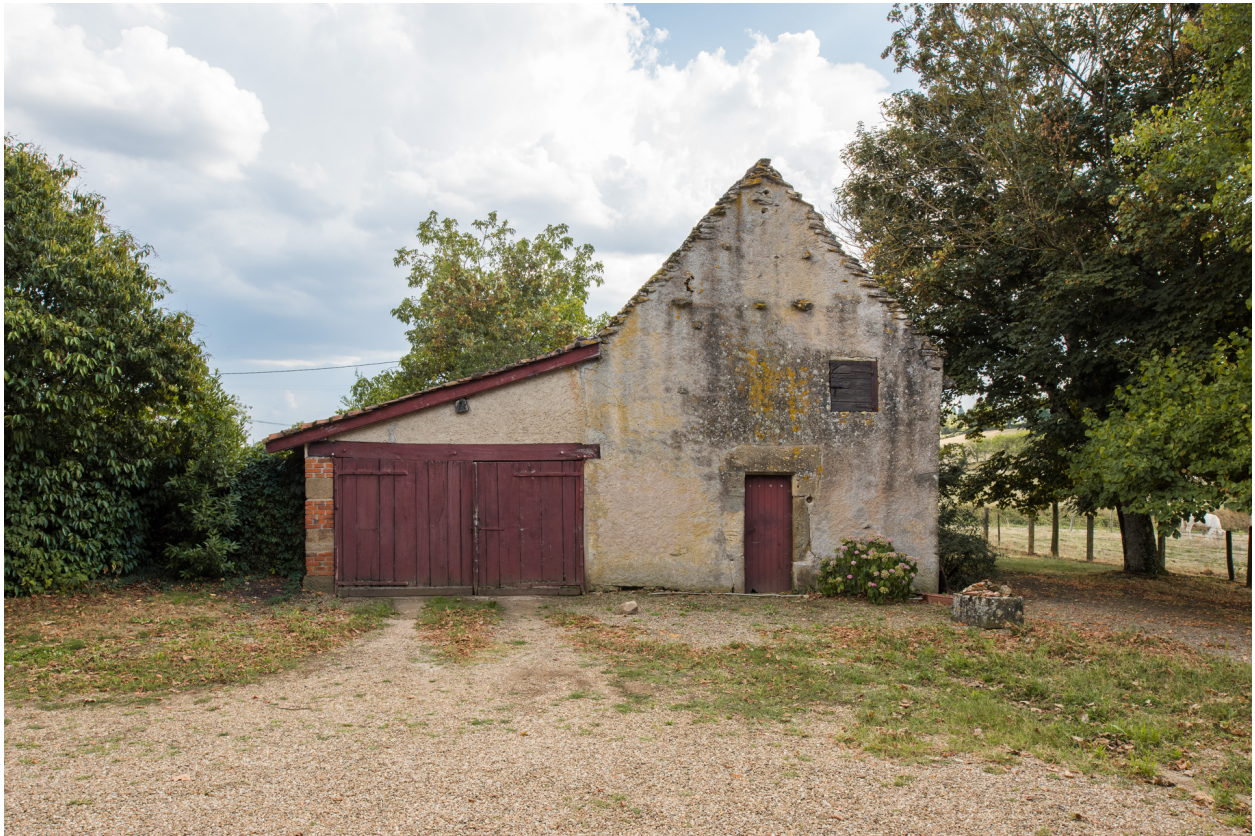
Vue de face de la façade antérieure - nord - des dépendances.
