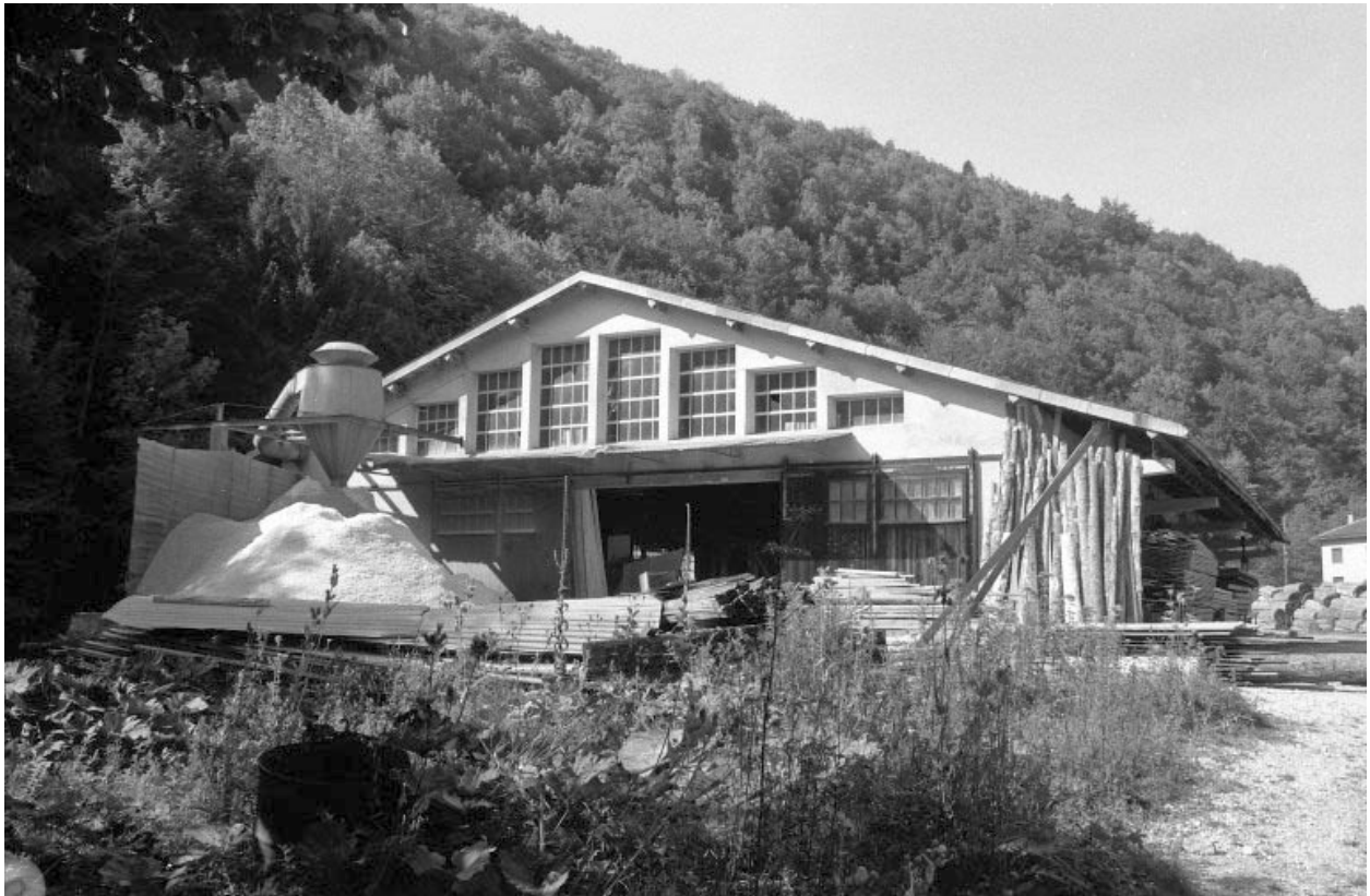
Façade postérieure de la scierie.
