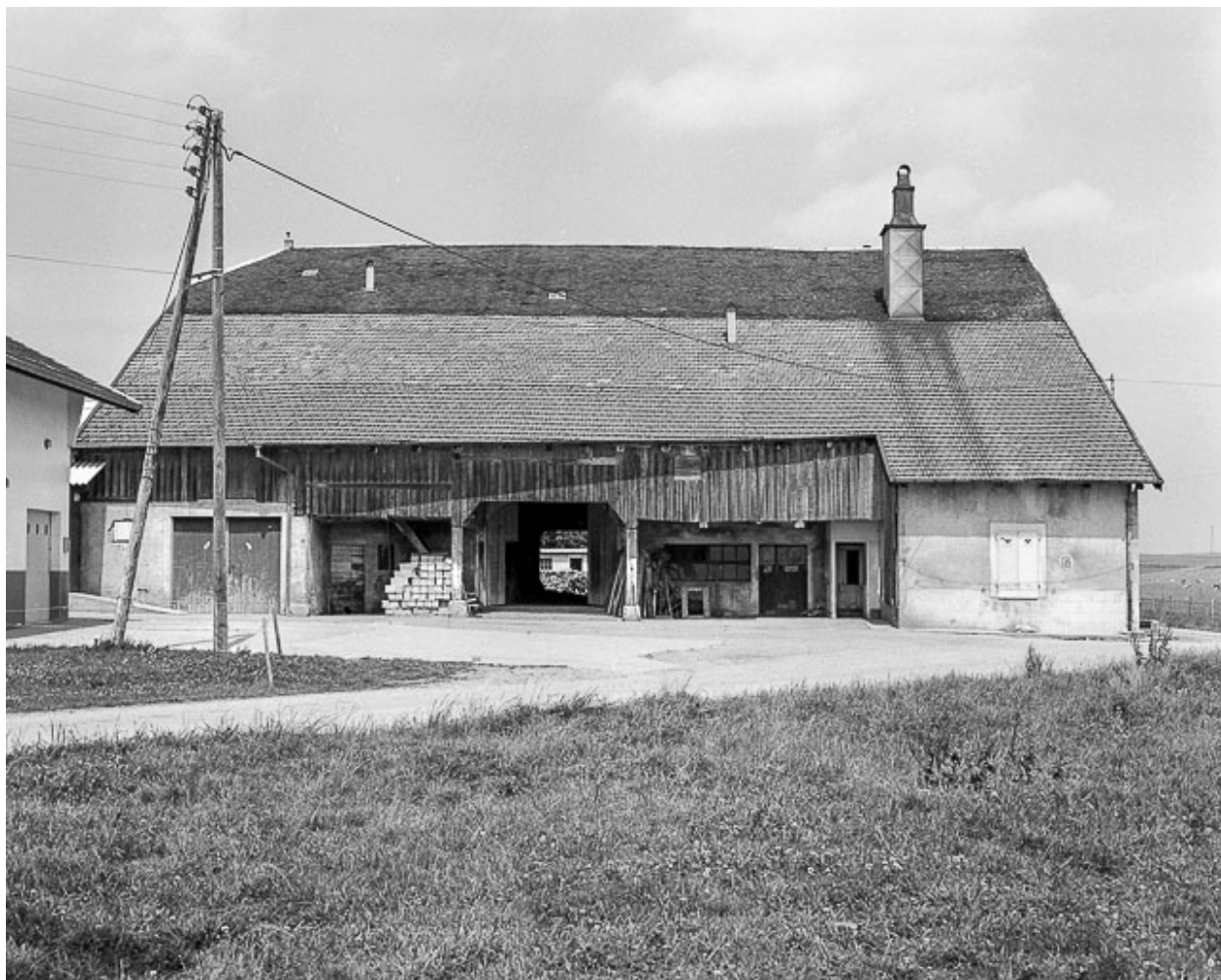
Façade latérale droite d'une ferme.
