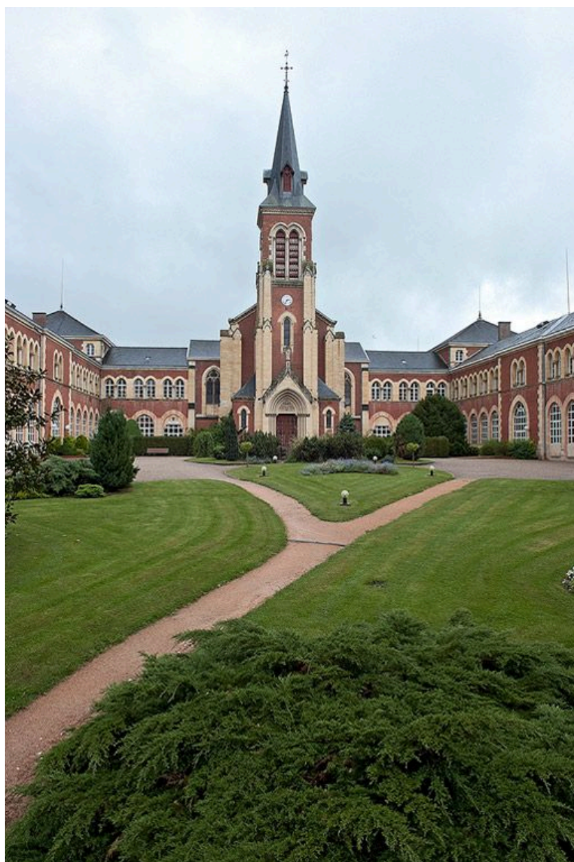
Façade de la chapelle.
