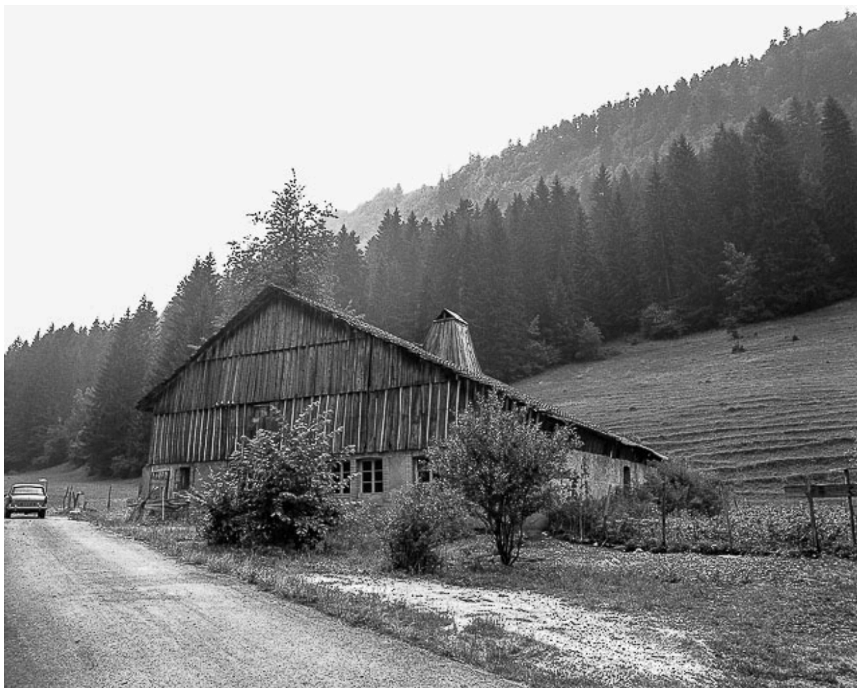
Ferme située au lieu-dit Le Theverot, cadastrée ZL 26 : vue d'ensemble.
