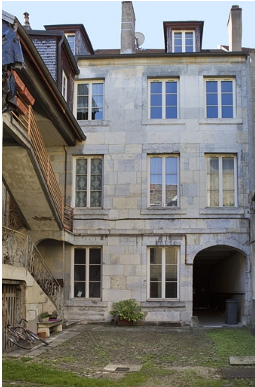
Façade postérieure du logis principal.
