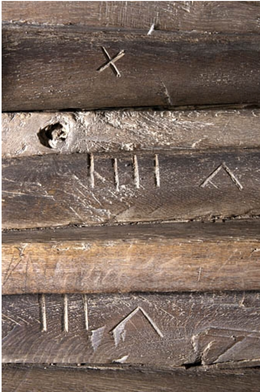
Intérieur : escalier en charpente menant à l'étage, détail des marches numérotées.
