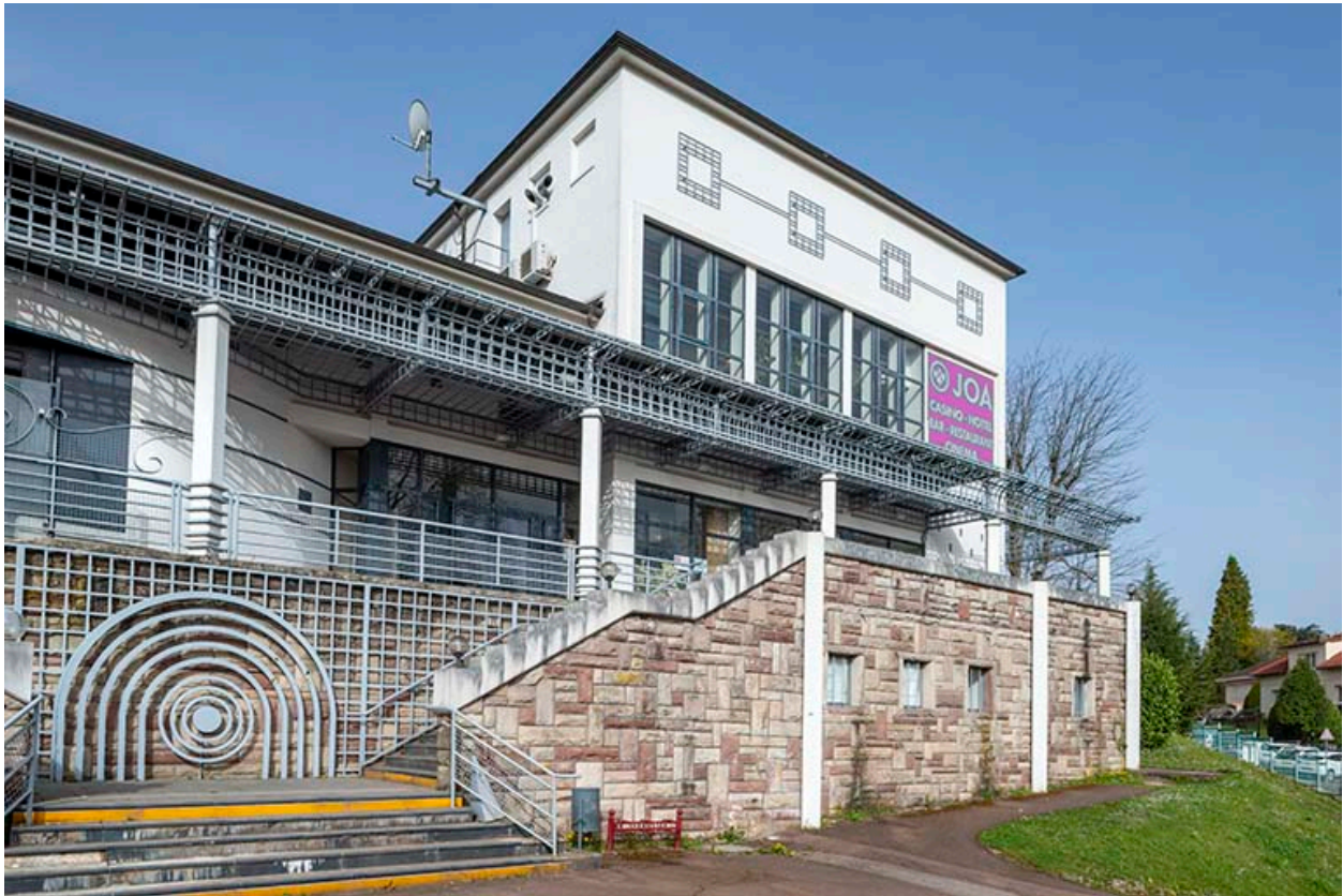
Salle des fêtes, vue depuis le sud-ouest.
