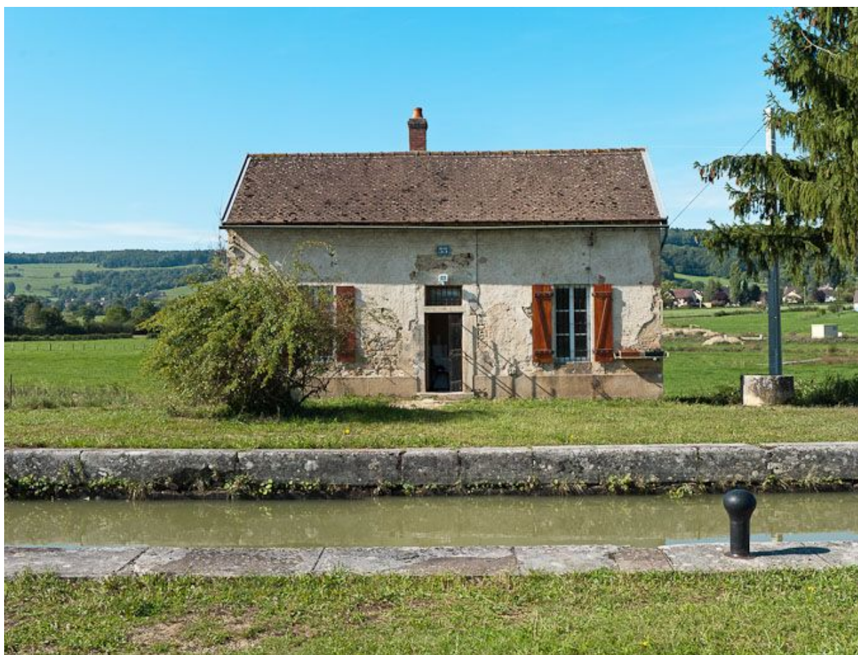
Vue de face de la maison éclusière.
