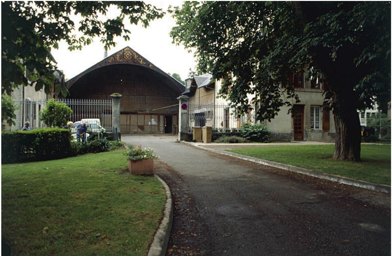
Les écuries depuis le nord.
