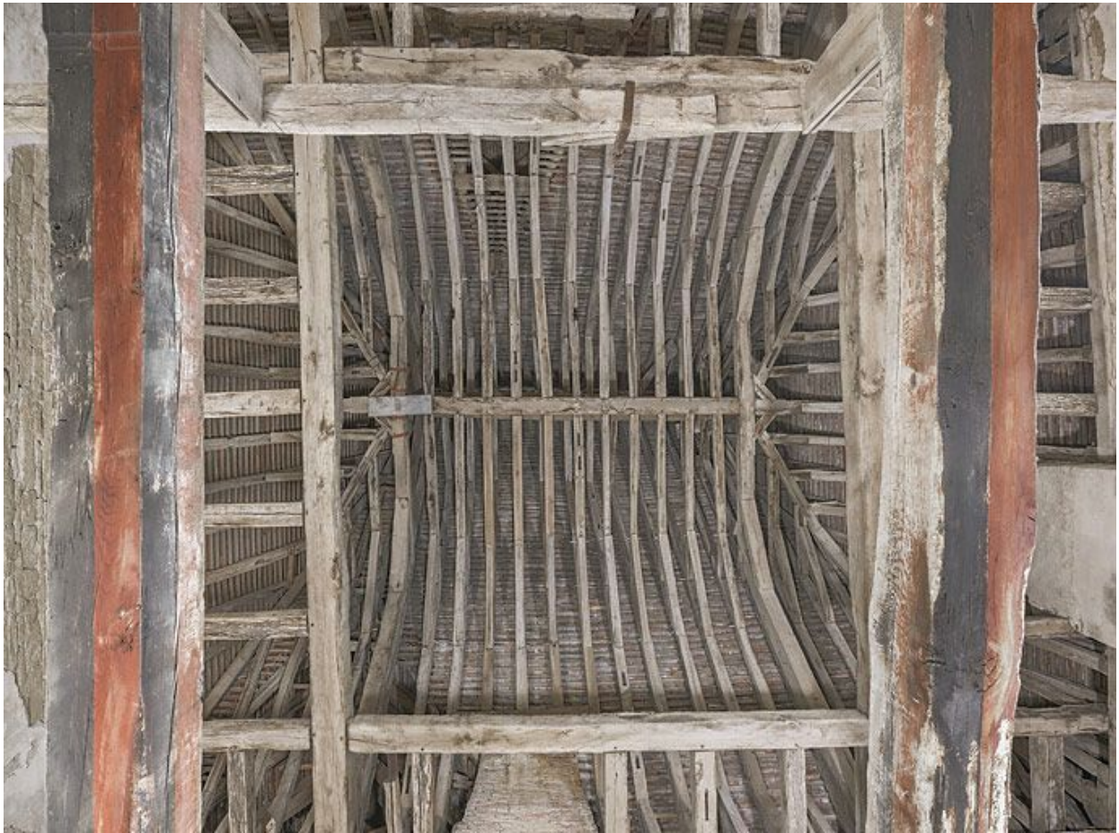
Combles : charpente de la tour carrée.
