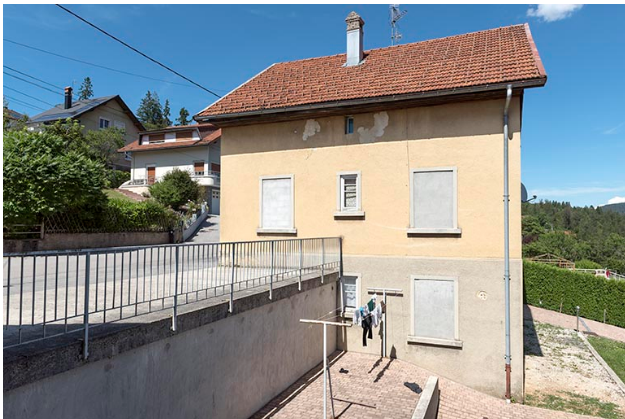
Façade latérale droite.
