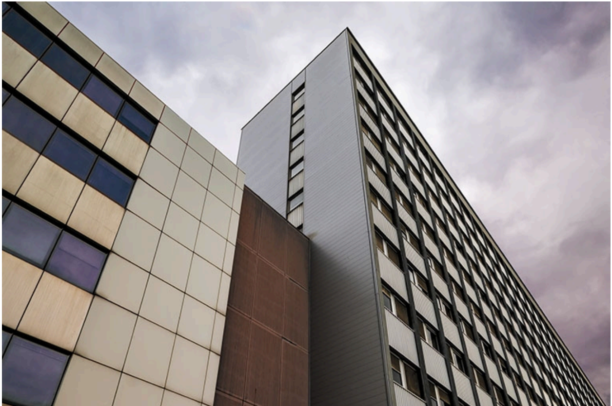
Entrée ouest. Bâtiment administratif et Centre de recherche (Building Ouest).
