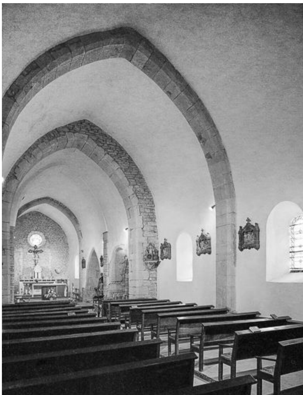
Elévation droite vue depuis l'entrée.
