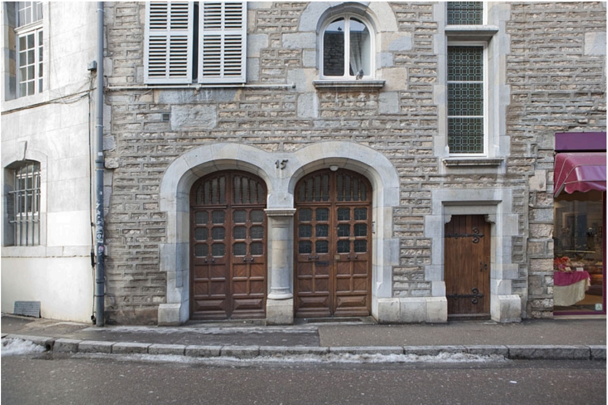
Façade rue Luc Breton : détail de l'entrée.
