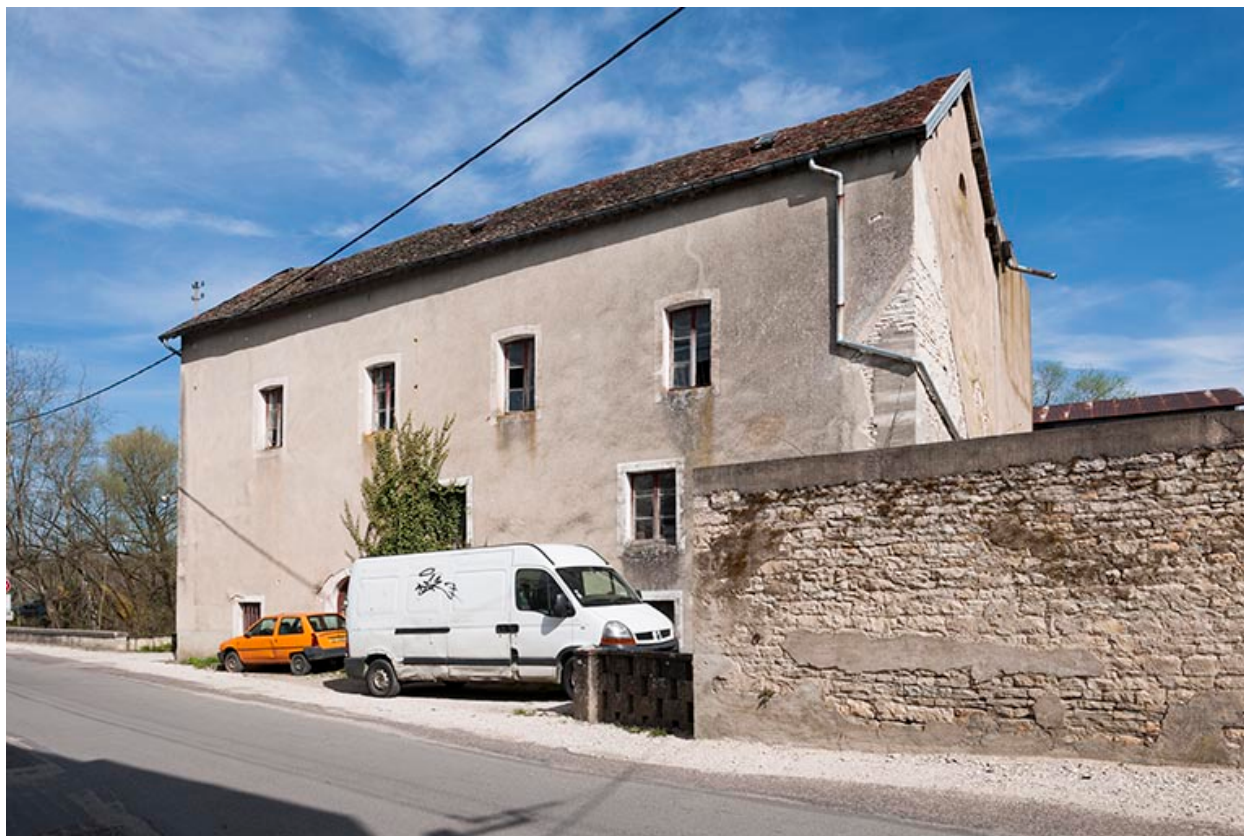
Façade sud de la minoterie.
