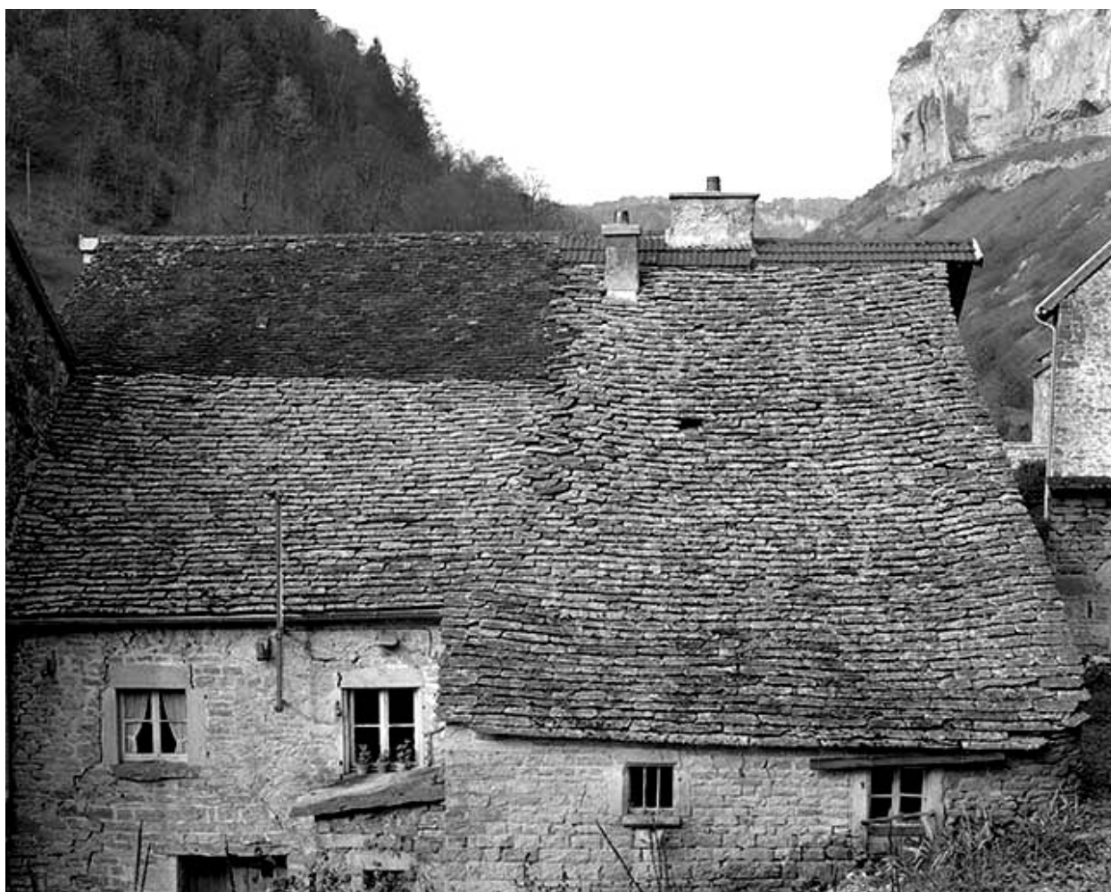
Détail d'une toiture en laves.
