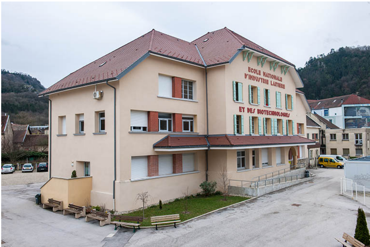
Façade antérieure principale de l'école, angle nord-ouest.
