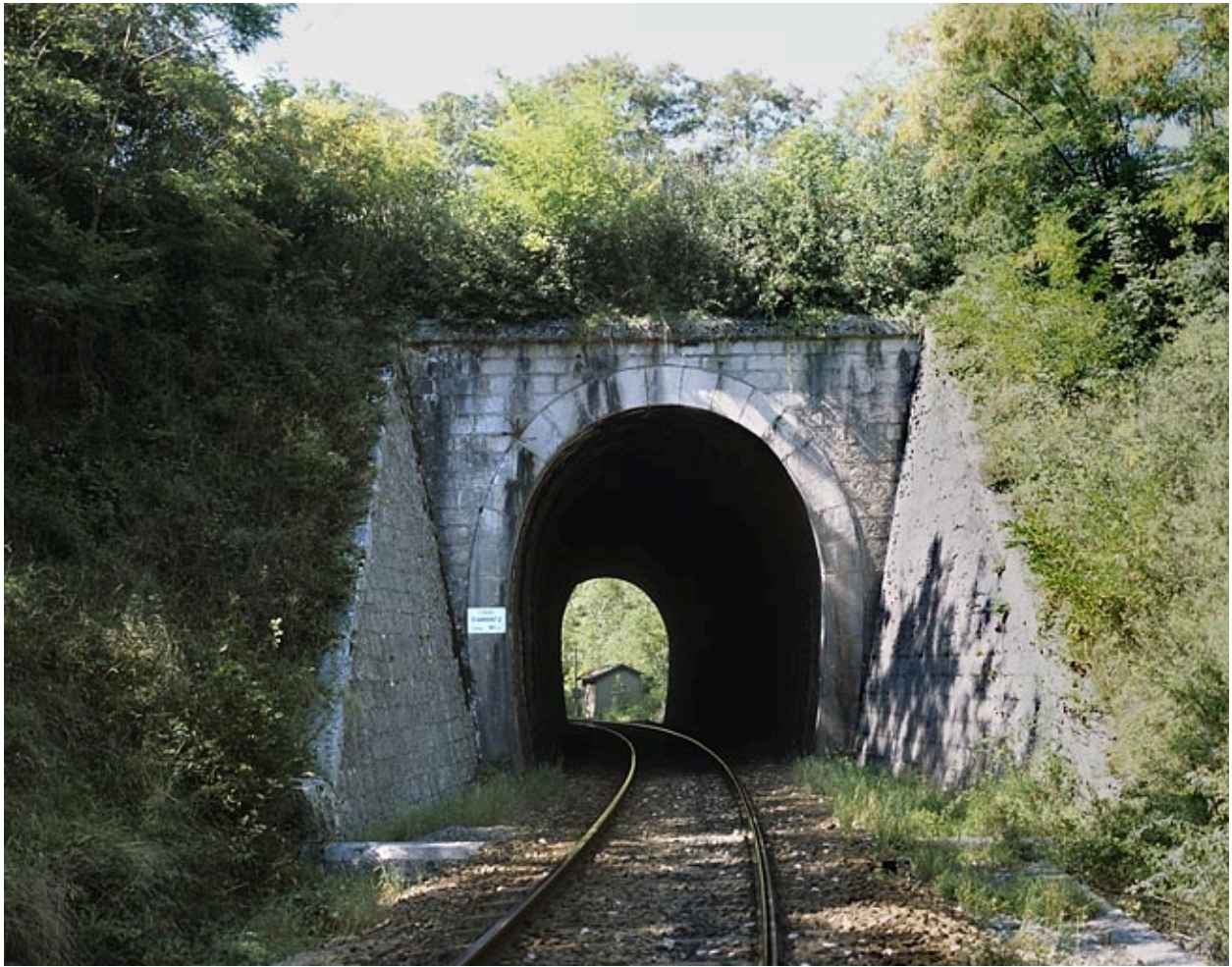
Tunnel d'Arbent 2 : tête côté La Cluse (est).
