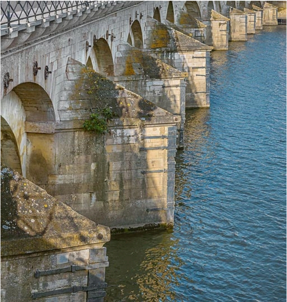
Les avant-becs du pont Saint-Laurent.
