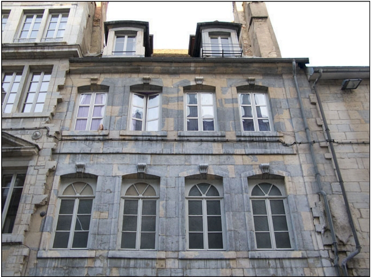
Détail des premier et deuxième étages de la façade antérieure du 13 Grande Rue : de face.
