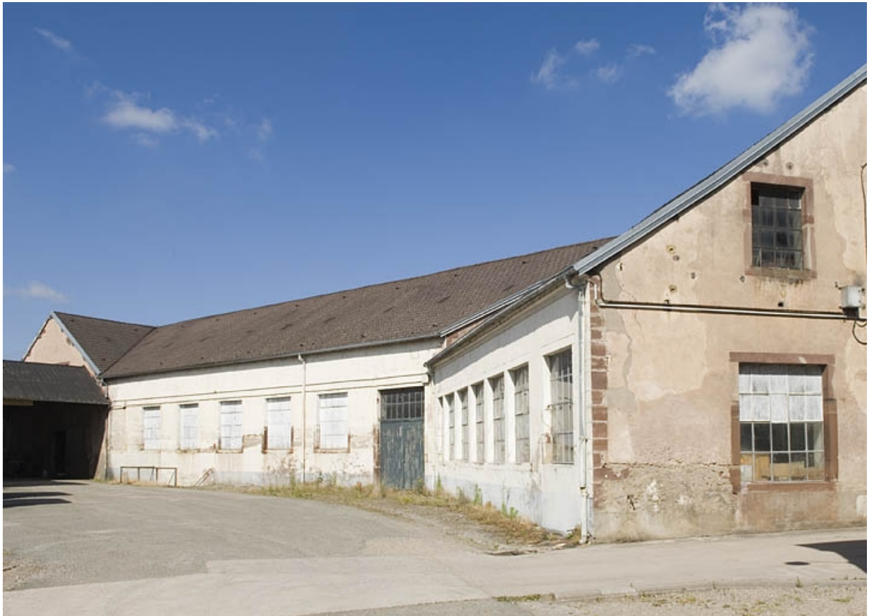
Atelier de fabrication originel. Vue depuis l'est.
