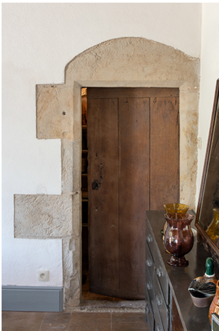
Grande salle, porte donnant sur une resserre sous l'escalier.
