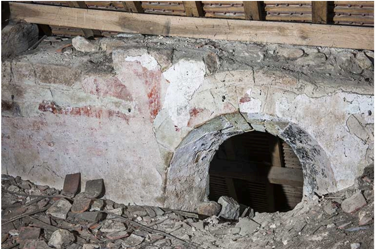
Ancienne baie en plein cintre située au-dessus de la voûte, avec traces d'enduit.
